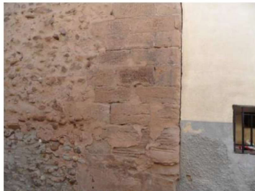
Detalle fábrica de sillería y mampostería
