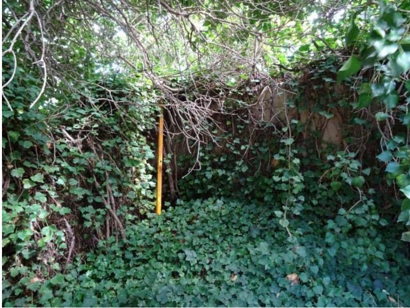
Muro existente junto a la edificación
