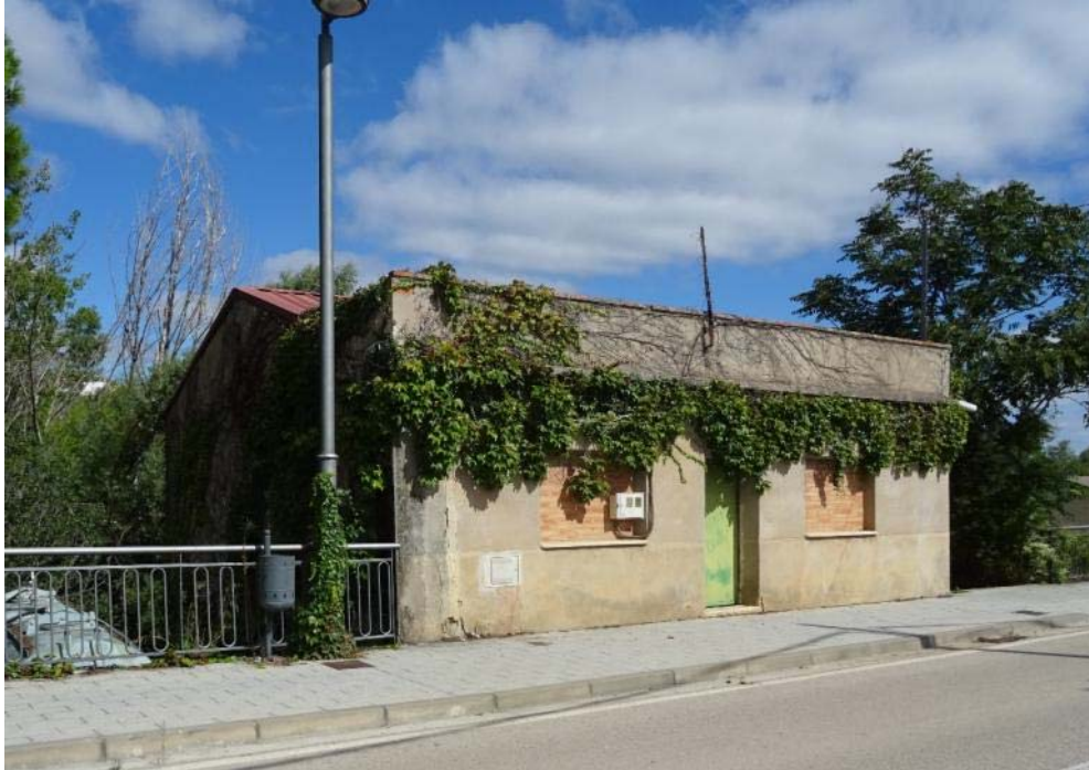
Edificación vista desde el Camino de Azagra
