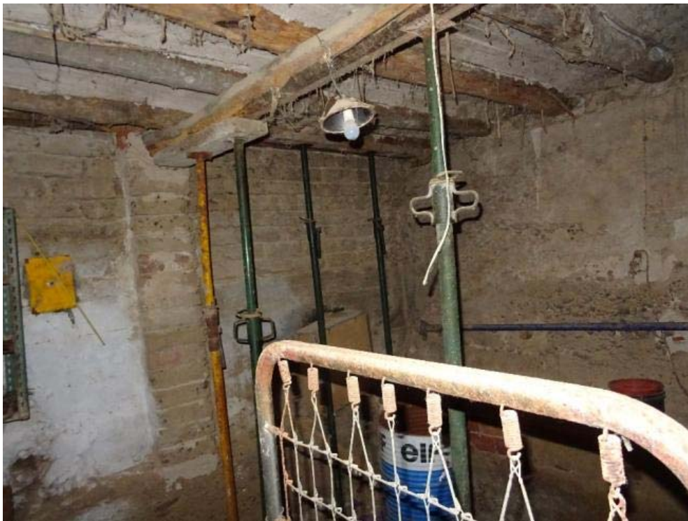
Zona de la planta inferior donde se han colocado puntales metálicos
