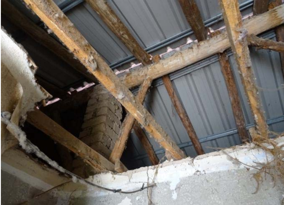
La desaparición parcial del falso techo permite apreciar la estructura de la cubierta y el acabado en chapa metálica.
