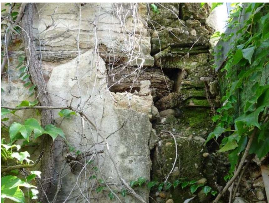
*Detalle de viga de madera desprotegida en su encuentro con el muro de la fachada sur*
