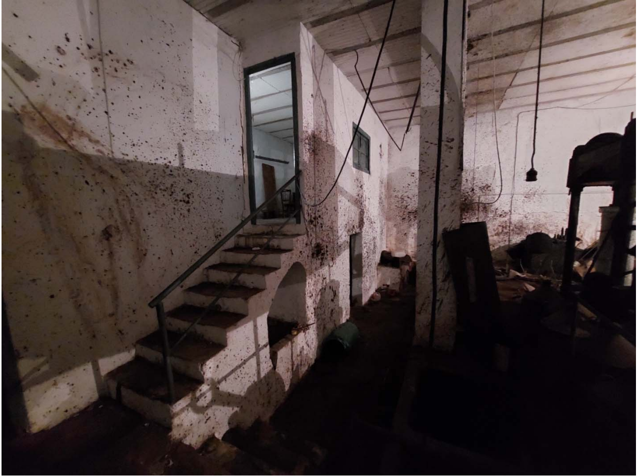
ZONA AL ESTE DONDE SE GENERA UN SEMISÓTANO.
