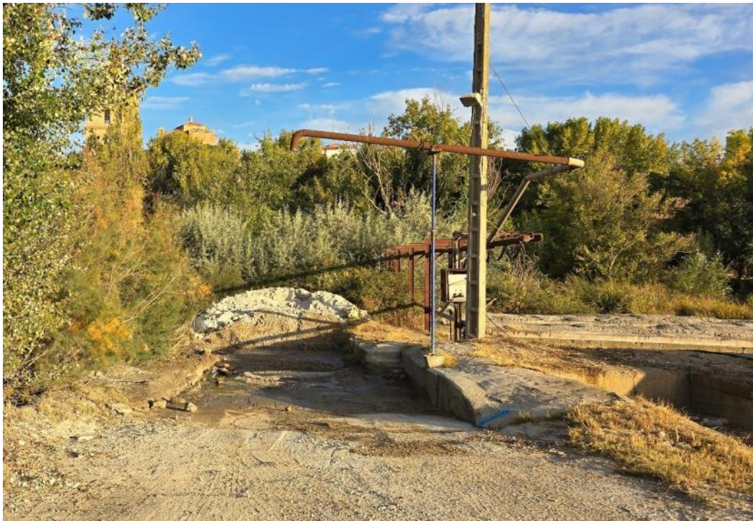
Vistas del foso existente en la parcela
