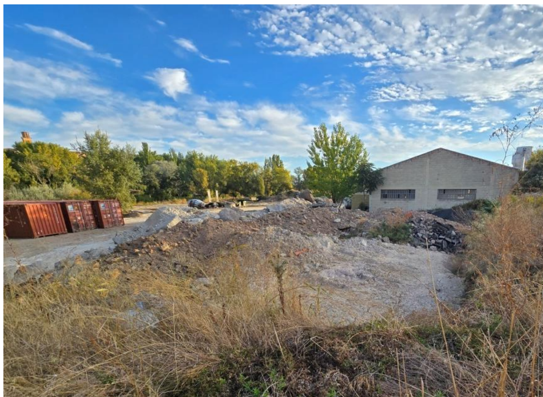
Contenedores y acumulación de materiales en la parcela.
