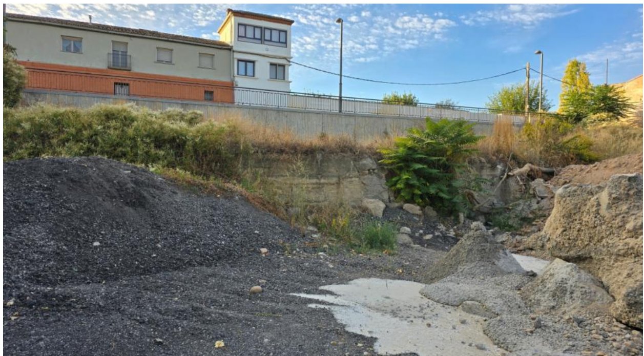
Vista más próxima del muro de hormigón en interior de la parcela. Al fondo, nuevamente muro y vallado de la Carretera de Azagra (exterior a la parcela).
