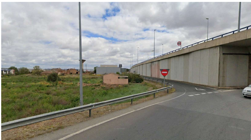
Detalle de infraestructura que interfiere en el asoleo del sector S7
