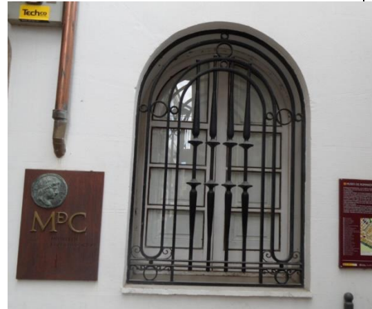
Detalle reja planta baja
