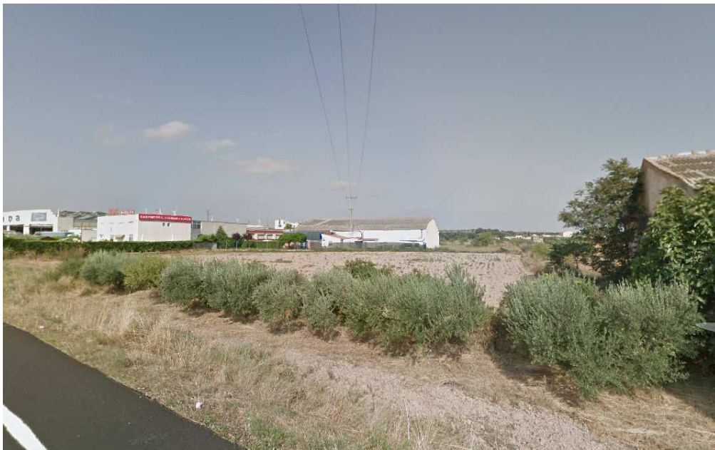
Perspectiva visual del ámbito (primer plano) desde la Variante de Calahorra, LR-134, al noreste.
